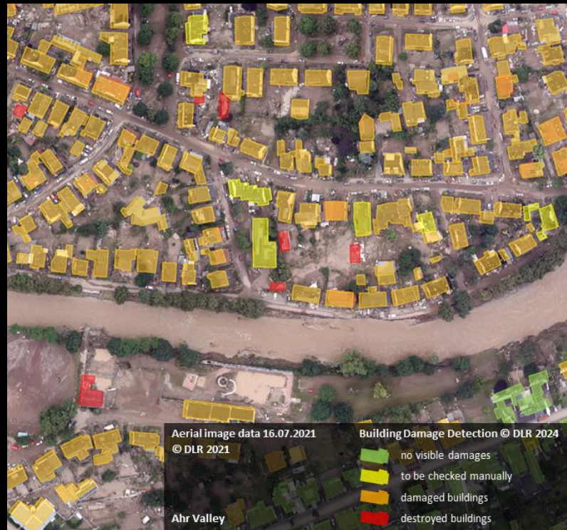
KI-basierte Detektion Gebäudeschäden bei Hochwasser, Deutschland
